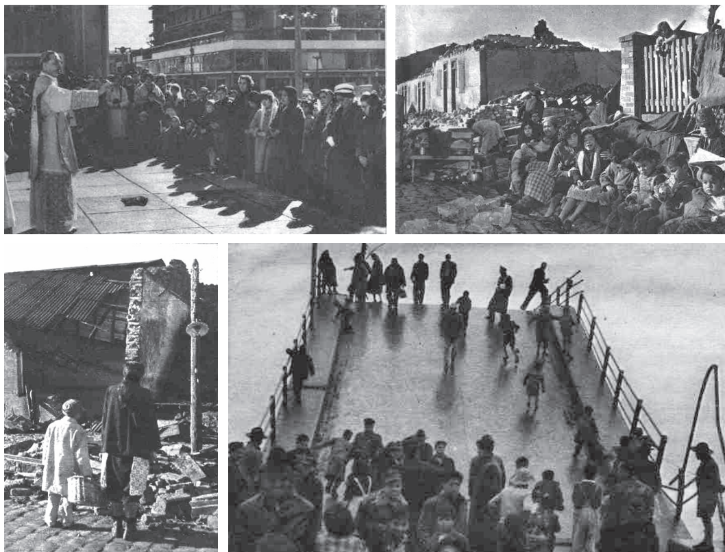
Figura N° 4 Imágenes posteriores al terremoto de 1960 en Concepción. Edificios dañados, misa a cielo abierto y puente sobre el río Biobío destruido
