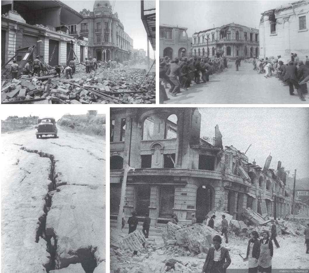
Figura N° 3 Imágenes posteriores al terremoto de 1939 en Concepción. Edificios y caminos afectados en el centro de la ciudad y alrededores
