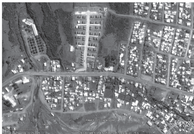
Figura N° 7 Ocupación informal de zonas de riesgo en sector Puente Soto, Quellón, 2005.
