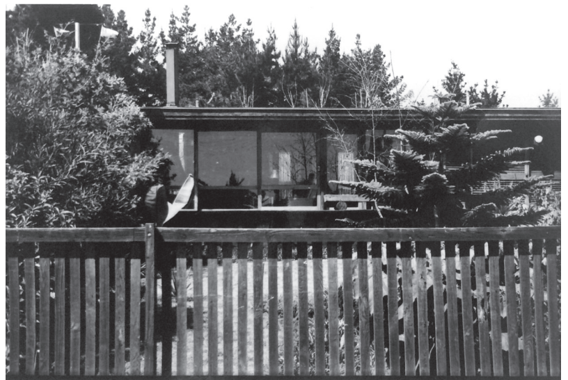
FIG. 06: Casa in Algarrobo (sin autor, s.f.). Fuente: Fondo Montserrat Palmer T. Archivo de Originales. FADEU. Pontificia Universidad Católica de Chile.
